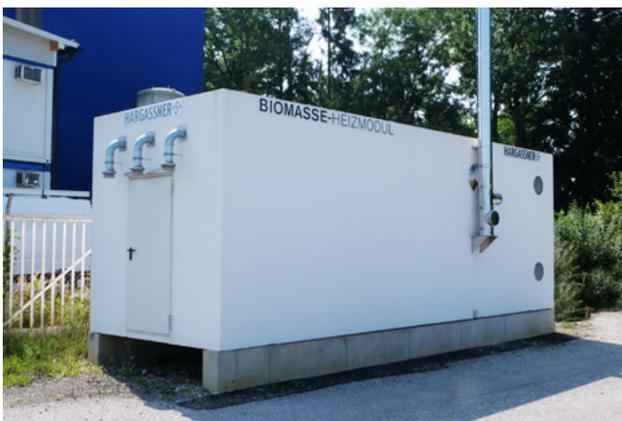
Einstock-Heizmodul 120 kW Pellets, Gewerbeobjekt
