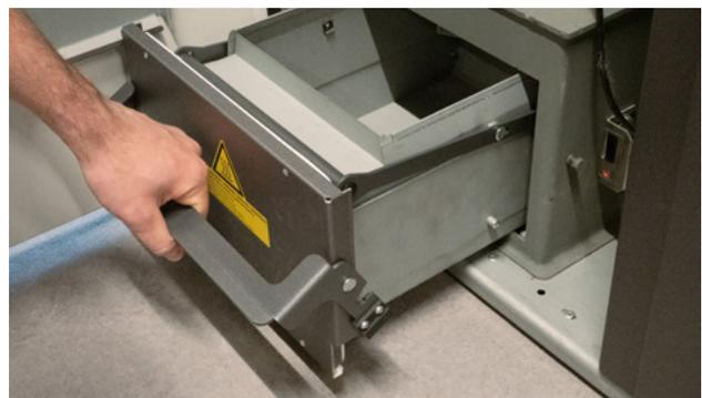
Je nach Heizdauer aktiviert sich eigenständig eine **Putzautomatik** für die Wärmetauscher. Das befreit die Kesselwände von Rückständen, die dann direkt in die Aschelade fallen.
