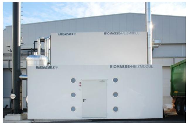
Mehrfach-Heizmodul 660 kW Hackgut, Industrie
